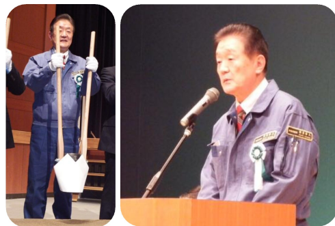
▲ 常総市で鬼怒川緊急対策プロジェクト着工式に出席。決壊した鬼怒川、八間堀川など無堤防地域の整備を行う計画です。
