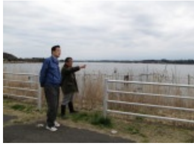
酒沼の堤防損壊現場を小林茨城町長と視察 (4/3)
