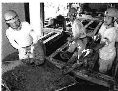
平成 21 年 山口県豪雨水害
