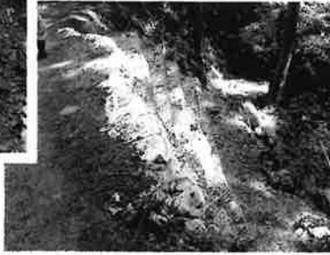
土砂崩れを起こした斜面に石段を造成
