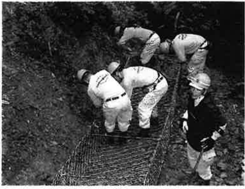
土砂崩れを起こした斜面に石段を造成
