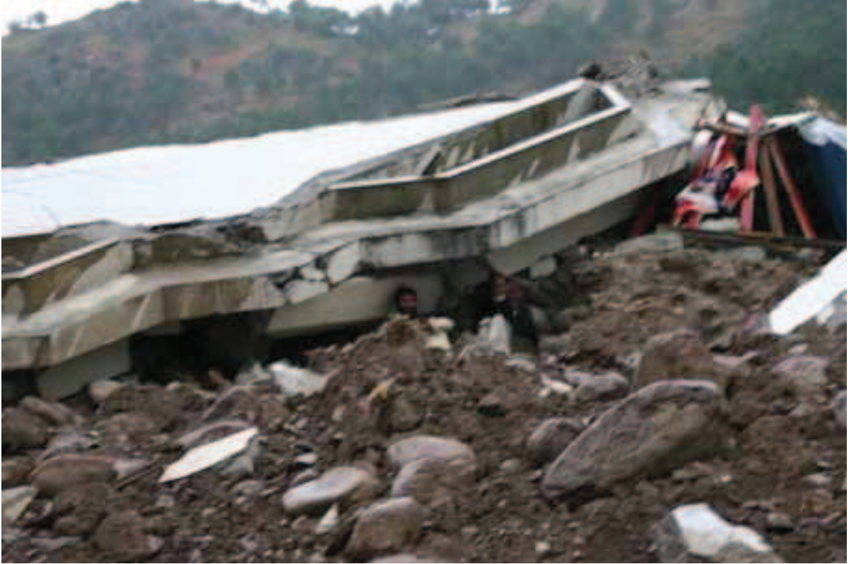
倒壊した建物で雨をしのぐ人たち
